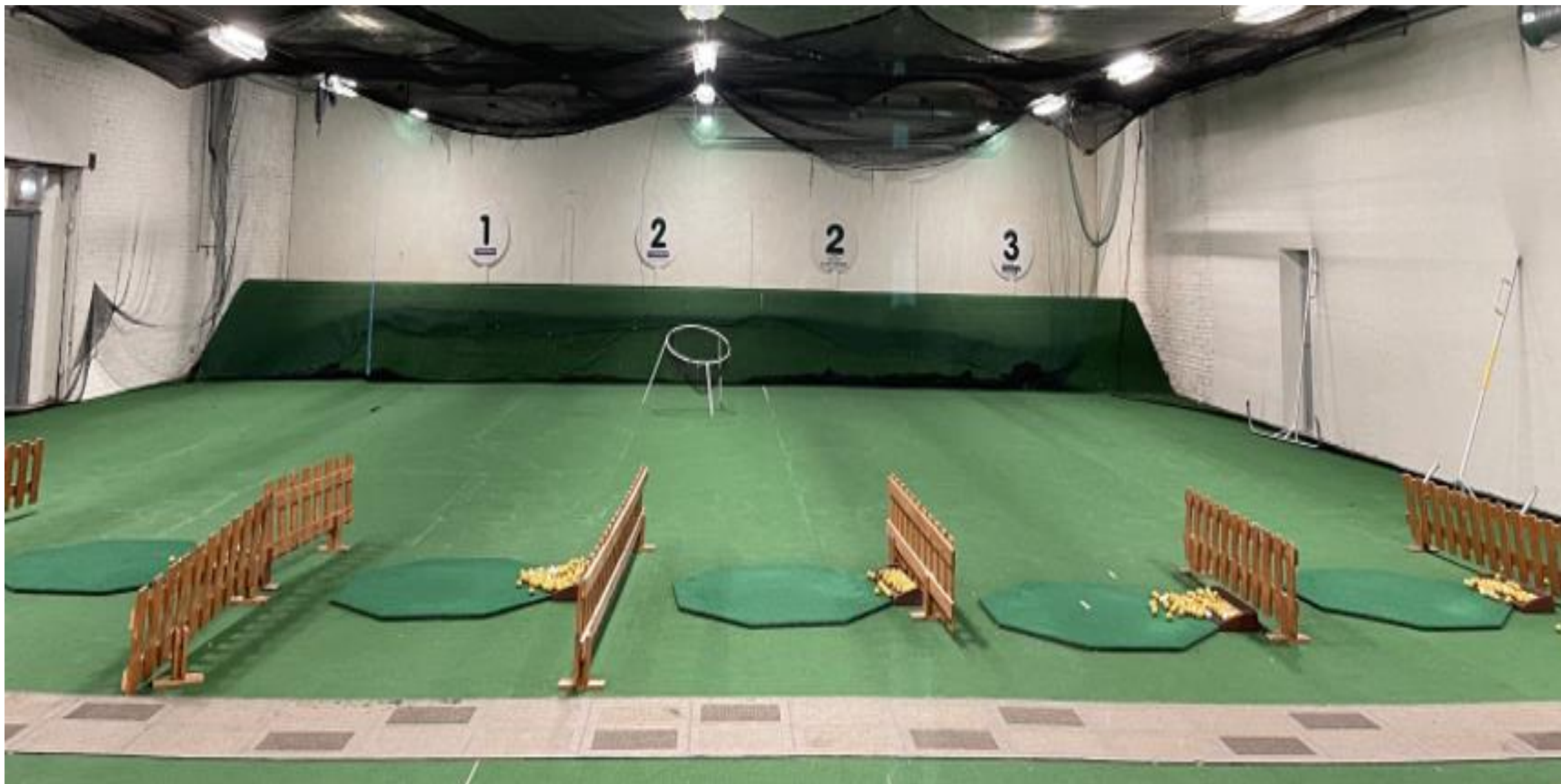
Golfhallen fått nytt nät i taket
